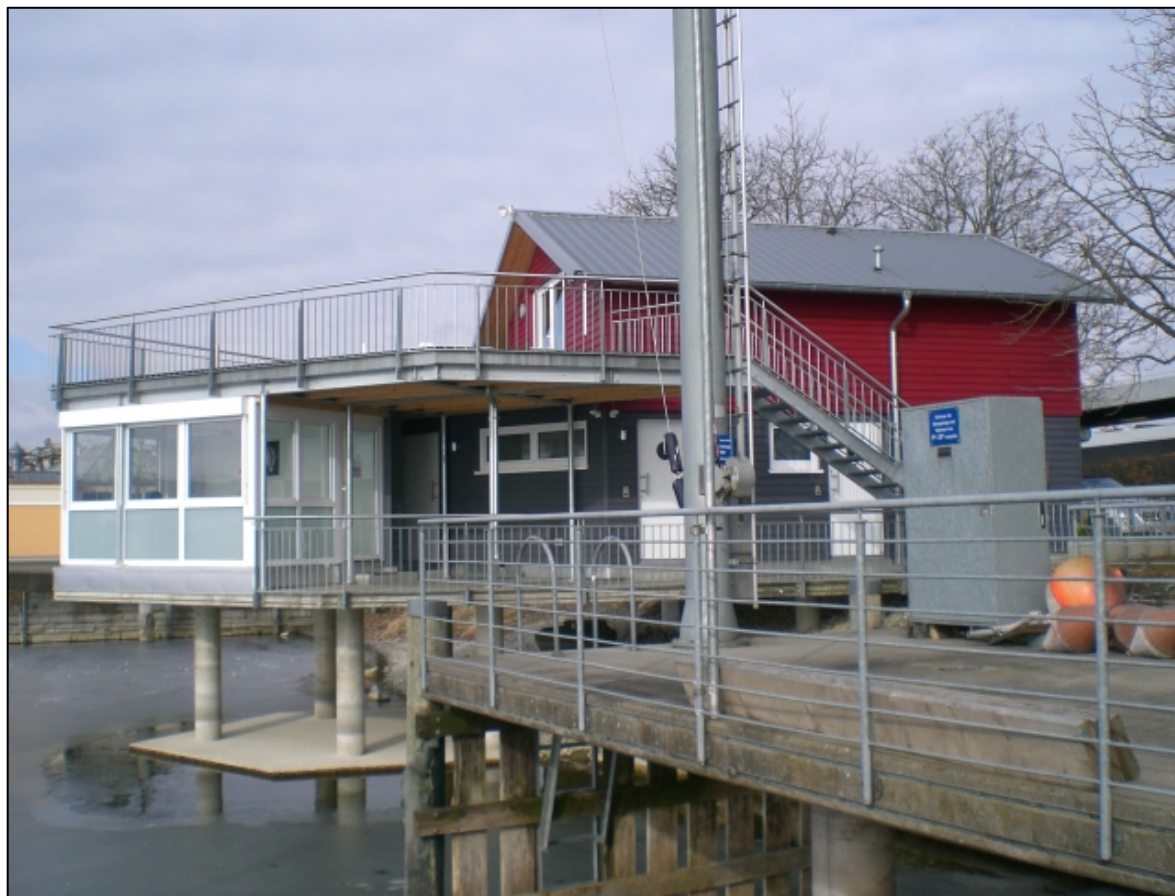
Das neue Hafenmeisterhaus im WWRa Hafen
