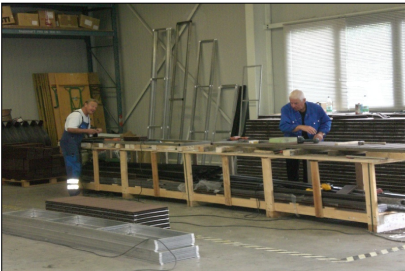
Vormontage der Auslegerroste
